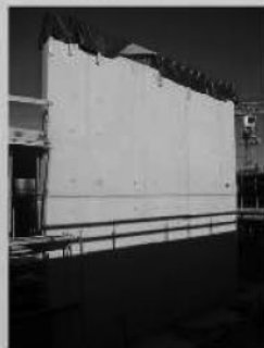
... a oto jakość betonowej ściany
